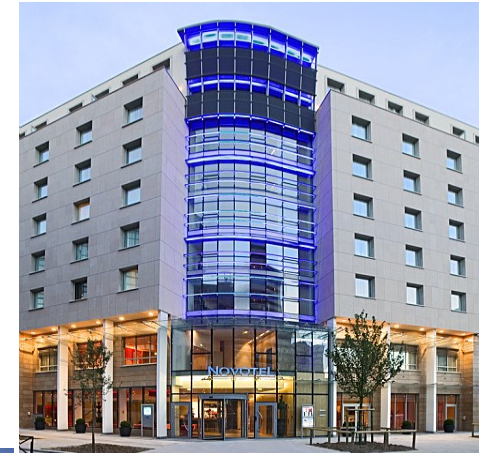
Novotel Gare Montparnasse
