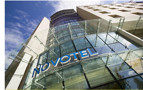
Novotel Gare Montparnasse
